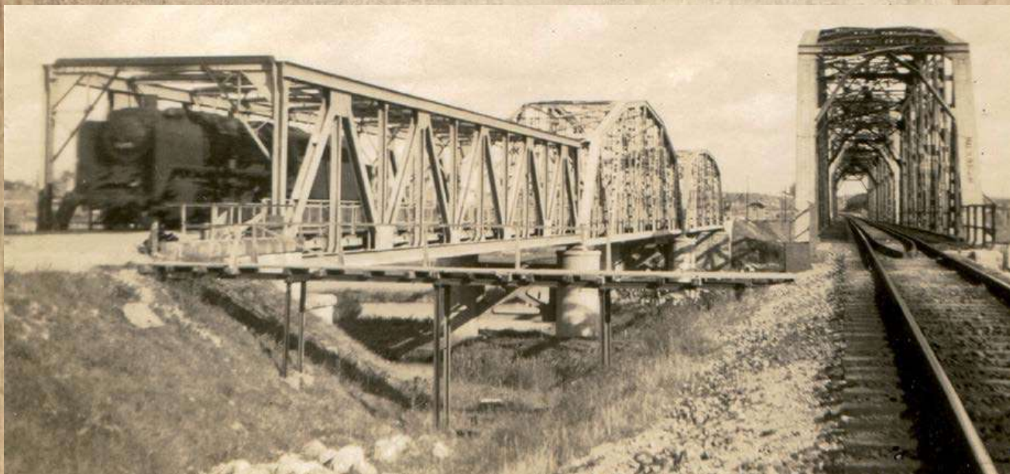
Mosty kolejowe na Narwi. Drugi most po prawej stronie został zbudowany w latach 30. XX wieku. Zdjęcie z epoki. [Zbiory autora]
