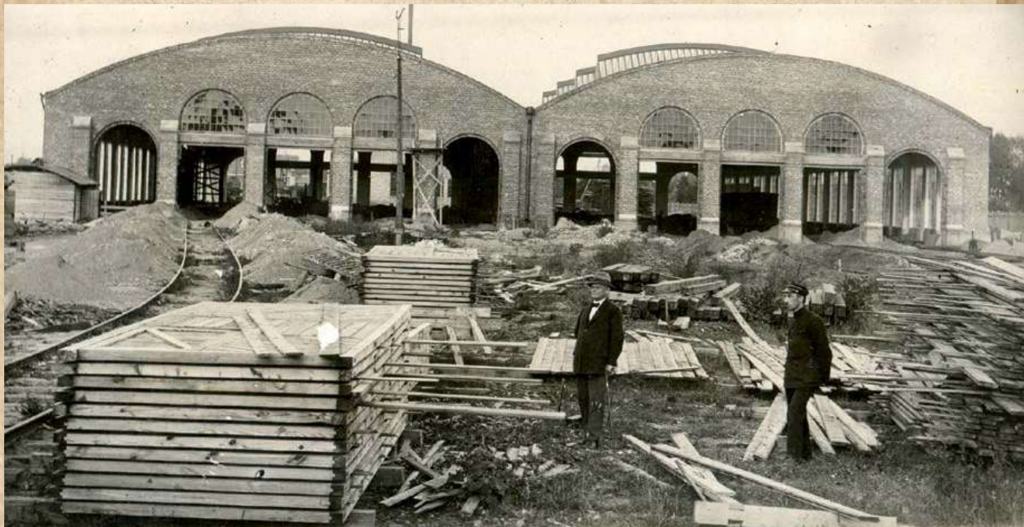
Budowa największej hali wagonowej na terenie warsztatów kolejowych w Łapach. W środku stoi naczelnik Rudolf Schmidt, 1925 r., [Zbiory autora]
